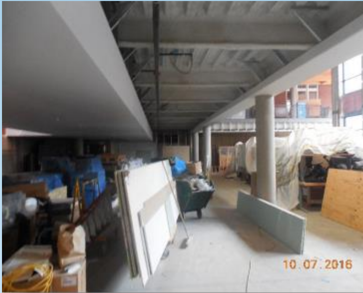
Commons Area in Progress
